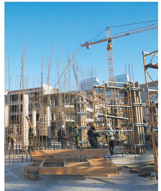
▲ Строительство школы на улице Советской в Екатеринбурге по концессионному соглашению завершится в декабре 2024 года. Фото: Елена Ельцова
