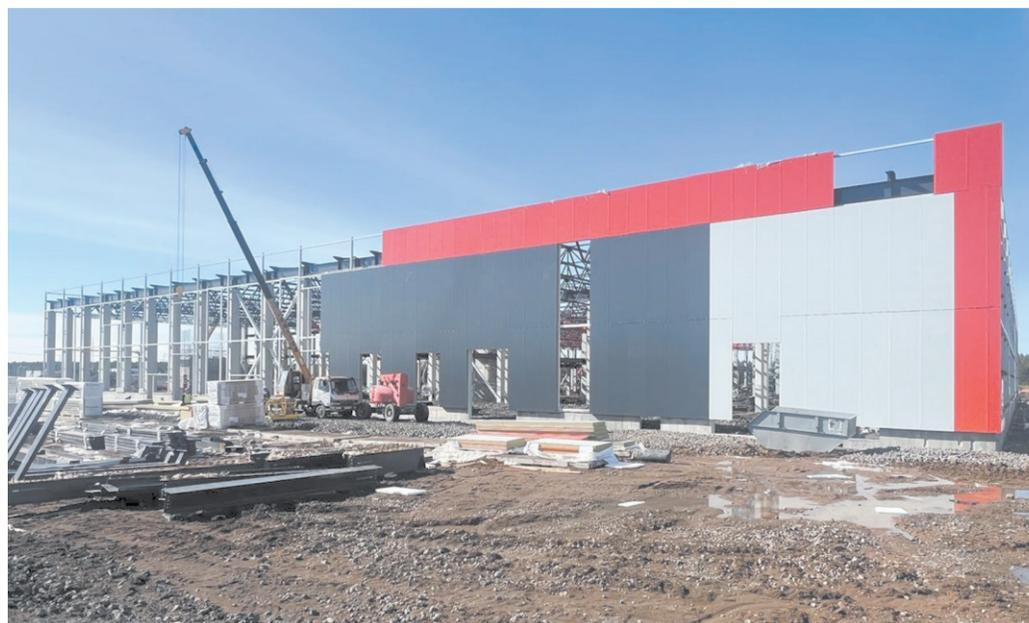
Здесь в настоящее время уже завершены значительные этапы строительства, такие как монтаж сэндвич-панелей на фасаде главного производственного корпуса, а также завершаются работы по возведению каркаса цеха механической обработки и упаковки. Параллельно с этим на площадку завозятся первые станки. Фото: ДИП Свердловской области
