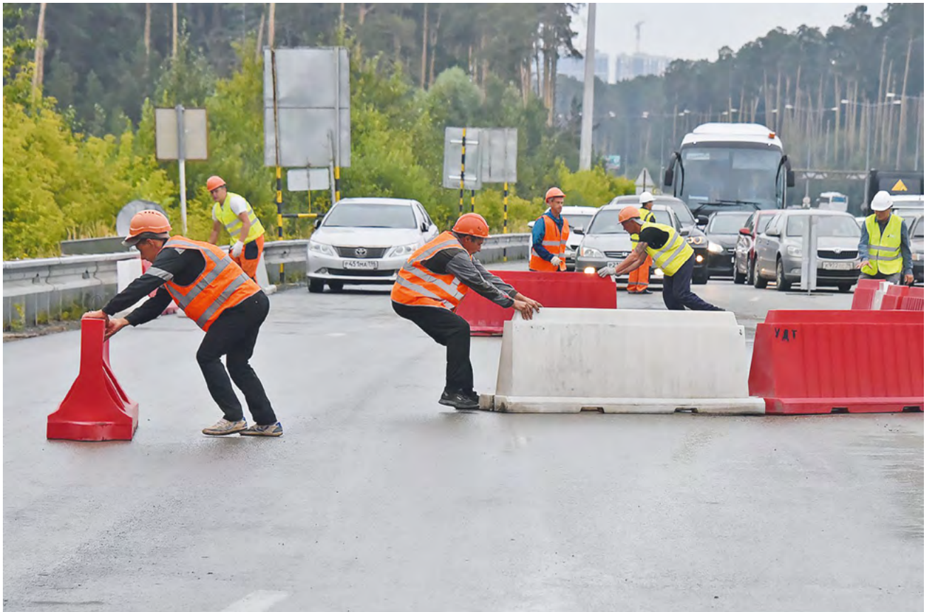
▲ Открылось сквозное движение по путепроводу на пересечении улицы Луганской с Обьездной автодорогой. На мосту, построенном в 2002 году, меняли асфальт и деформационные швы, установили водоотводы и барьеры. Фото: Борис Ярков
