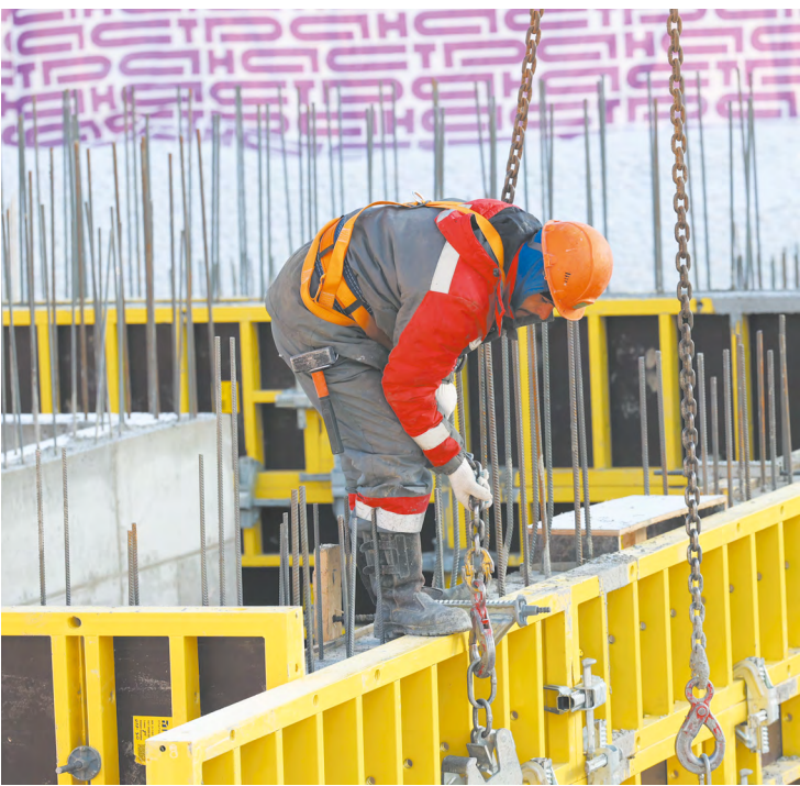
▲ Строители завершили нулевой цикл первого проекта комплексного развития территории жилой застройки в Екатеринбурге. Фото: Елена Ельцова
